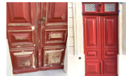
Porte d'entrée repeinte
